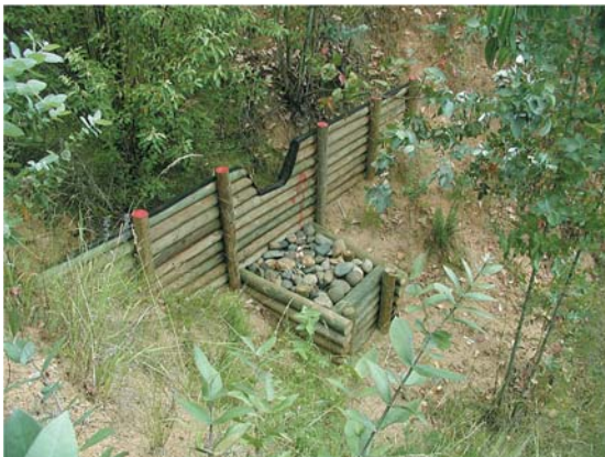
土砂流出防止柵の設置
