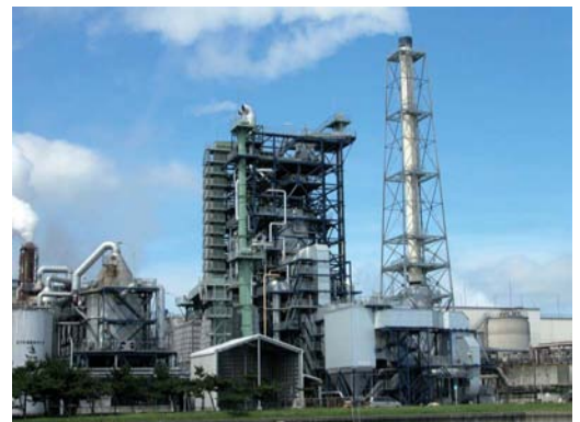
八戸工場リサイクルボイラー
