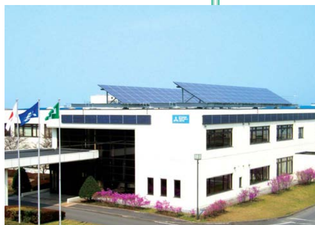
八戸工場の太陽光発電システム
