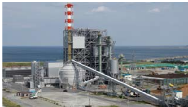
バイオマス発電設備全景
